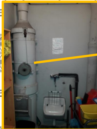
S58: VIDE ORDURE EN FIBRE CIMENT
