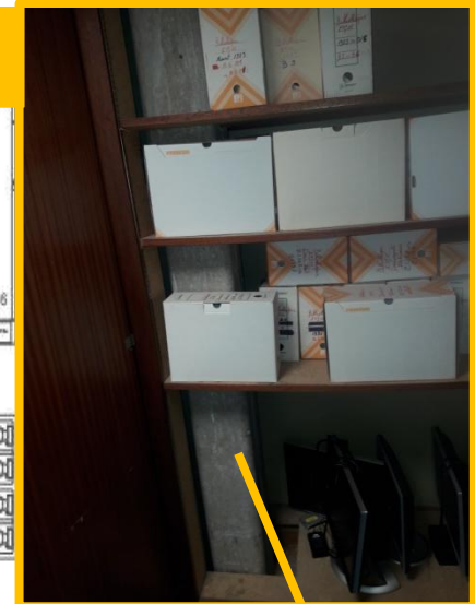
S60: CONDUITE FIBRE CIMENT
